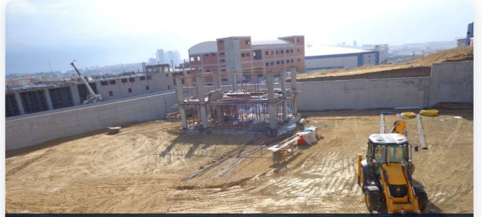
Mustafa Bora Geri Dönüşüm Tesisi Merkez Binası
