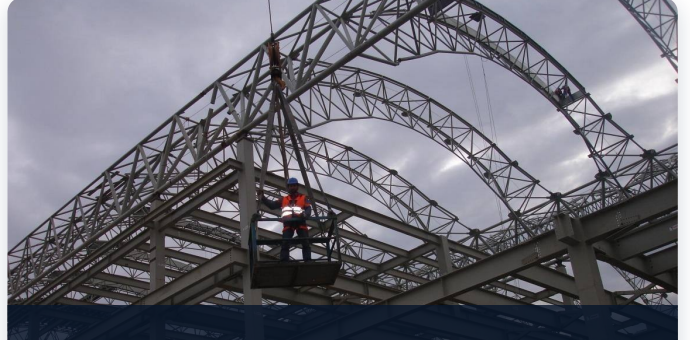
Sabiha Gökçen Havaalanı Terminal İnşaatı — Çelik Çatı Konstrüksiyonu
